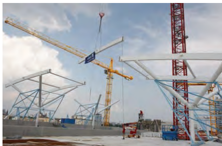
Bild 20: Rheinseitige Baumstütze mit Hilfsgerüst © Vollack Bautechnik GmbH & Co. KG
