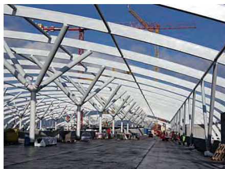
Bild 11: Baum- und V-Stützen © Vollack Bautechnik GmbH & Co. KG
