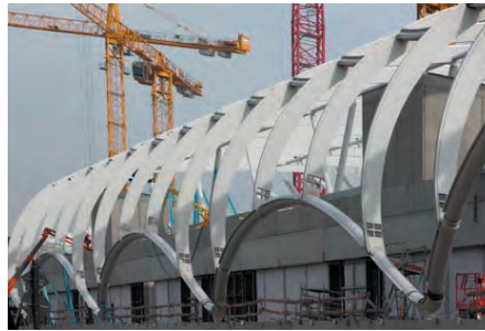
Bild 10: Längsrohrbinder mit festen Auflagern © Vollack Bautechnik GmbH & Co. KG
