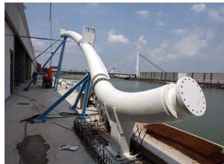
Bild 18: Hilfsgerüst der Längsbinder © Vollack Bautechnik GmbH & Co. KG
