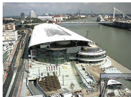
Bild 23: Baustelle am 10. August 2010 © Vollack Bautechnik GmbH & Co. KG
