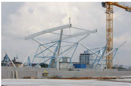
Bild 19: Stadtseitige Baumstütze mit Hilfsgerüst © Vollack Bautechnik GmbH & Co. KG
