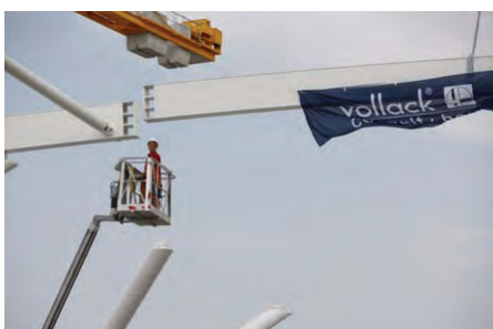
Bild 21: Einfahren der Schlussträger © Vollack Bautechnik GmbH & Co. KG
