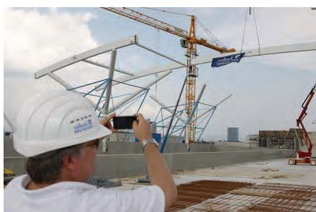
Bild 22: Lückenschluss der Dachbinder © Vollack Bautechnik GmbH & Co. KG
