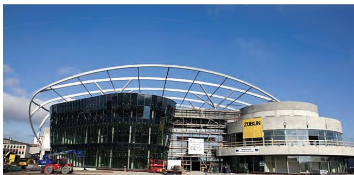
Bild 9: Dach mit Giebelbindern © Vollack Bautechnik GmbH & Co. KG
